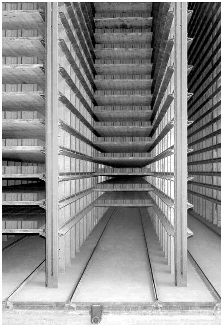
Il risultato che si può vedere è un'installazione perfetta in piano e altezza.
