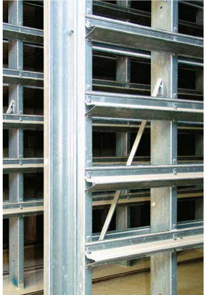
Auflageprofile mit durchgehender seitlicher Führung und Spezialverzinkung.
