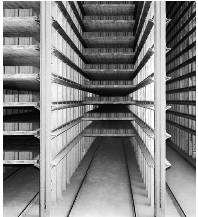
Flucht- und höhengerechte Montage der Kammern.
