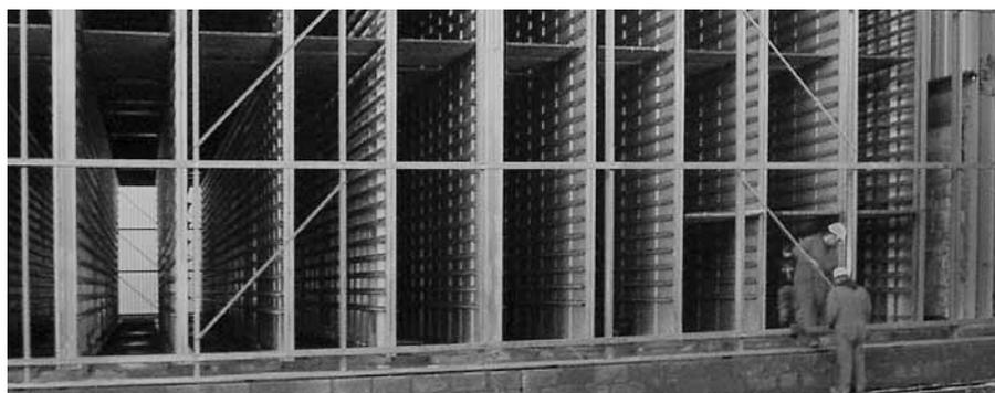
Estructura de acero del pabellón con cámaras de endurecimiento y desecación; el revestimiento se realiza posteriormente – Montaje sin problemas
